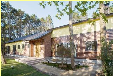
【湯布院ロッジ】 大分県湯布院町
